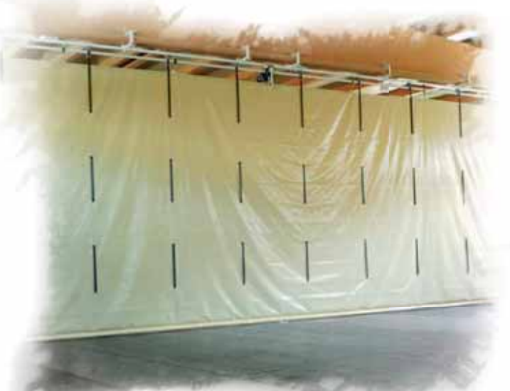
Instalación de cortina división en polideportivo.
