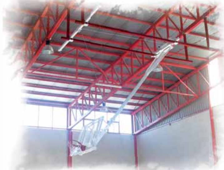
Instalación de canasta motorizada polideportivo
