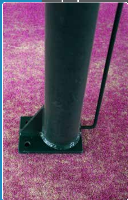
Detalle base Poste Metálico Tenis
